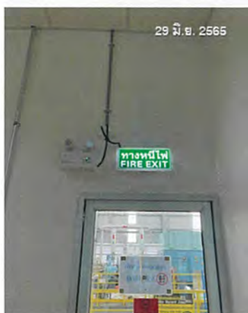
รูปที่ 88 ไฟส่องสว่างฉุกเฉินภายในพื้นที่โครงการ
