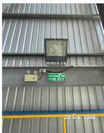
รูปที่ 88 ไฟส่องสว่างฉุกเฉินภายในพื้นที่โครงการ
