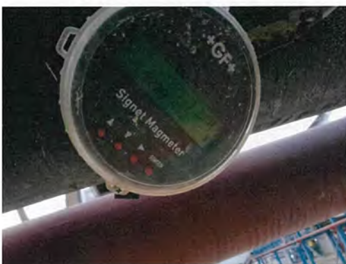
รูปที่ 27 Flow meter บริเวณระบบบำบัดน้ำเสีย
