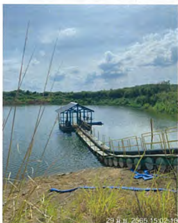
รูปที่ 50 เครื่องสูบน้ำและแพสูบน้ำบริเวณบ่อเก็บน้ำดิบ
