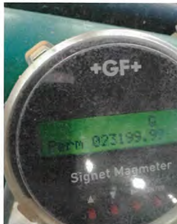
รูปที่ 49 มิเตอร์วัดน้ำบริเวณบ่อเก็บน้ำดิบ
