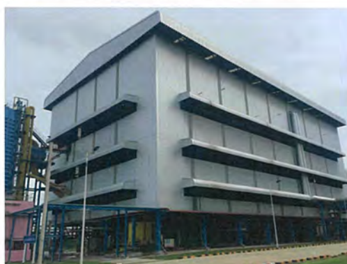
รูปที่ 89 การปิดครอบแหล่งกำเนิดเครื่องจักรที่มีเสียงดัง
