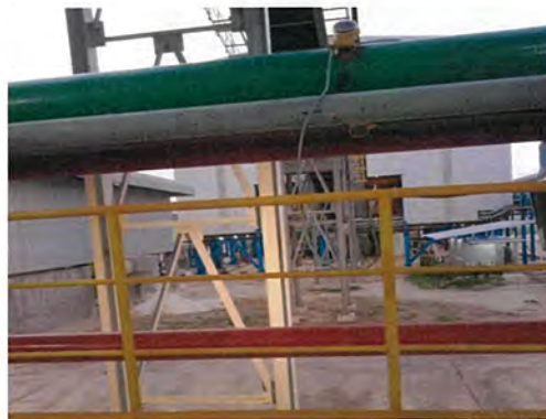
รูปที่ 27 Flow meter บริเวณระบบบำบัดน้ำเสีย
