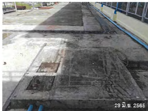
รูปที่ 56 บ่อแยกน้ำและน้ำมัน
