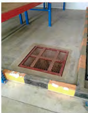
รูปที่ 82 รางระบายน้ำและบ่อรวบรวมน้ำบริเวณอาคารเก็บสารเคมี
