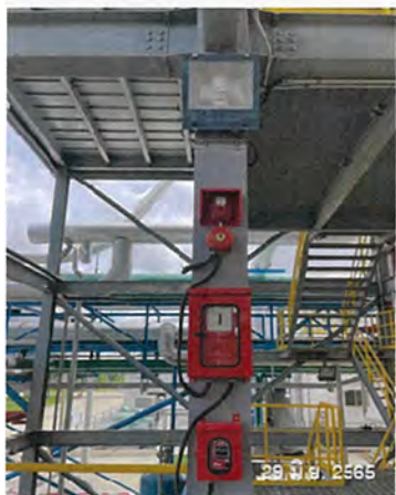
รูปที่ 86 ระบบตรวจสอบ ตรวจจับและสัญญาณเตือนภัย
